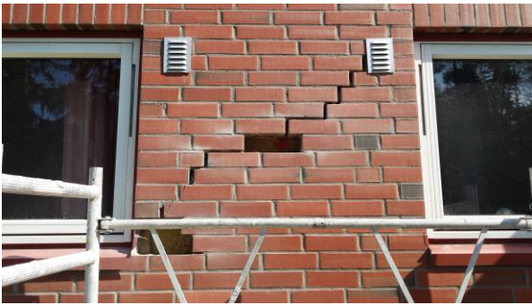
Her er et bilde etter at murpuss og stein er fjernet.
